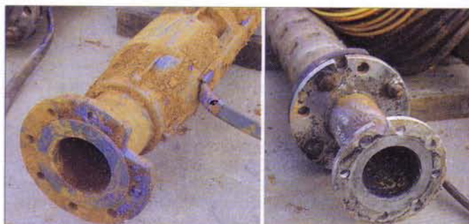
Abb. 2: Verockerte und mit Inox-Cleaner gereinigte Pumpe
