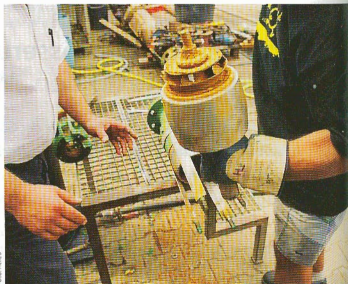
■ Schnell ist die Hydraulik einer Unterwasserpumpe verschmutzt.
